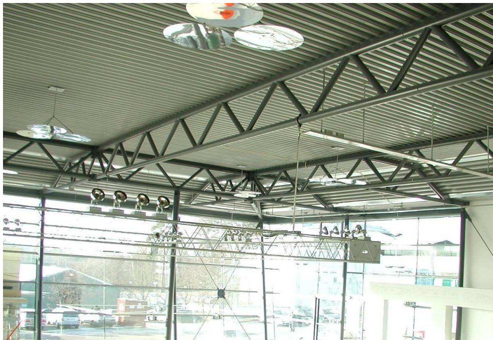
Rysunek 1.1 Budynek przemysłowy, w którym zastosowano działanie tarczownicowe naprężonej powłoki
