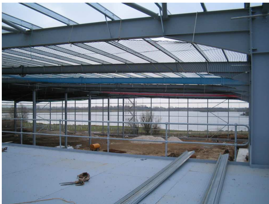
Rysunek 5.4 Szczegół zastrzałów rygla (zaczepnięte z Caunton Engineering Ltd)
