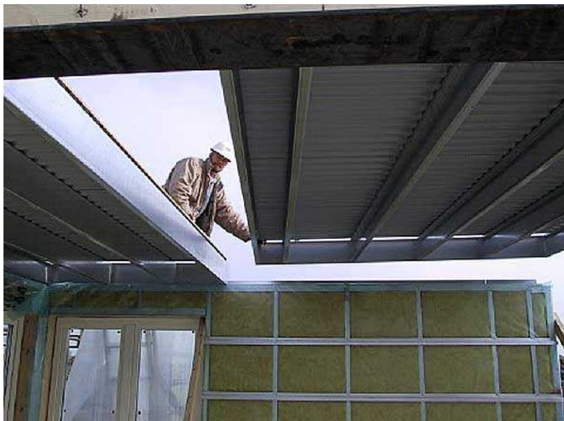
Rys. 2.5 Montaż prefabrykowanego elementu stropowego (Źródło: Lindab Profil AB)
