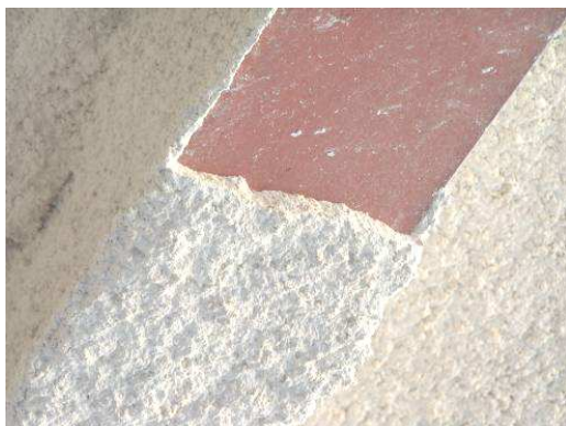
Rys. 5.1 Szczegół półki przekroju zabezpieczonej natryskiem
