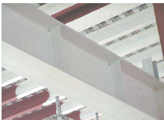
Rys. 5.2 Powłoki pęczniące na belce antresoli
