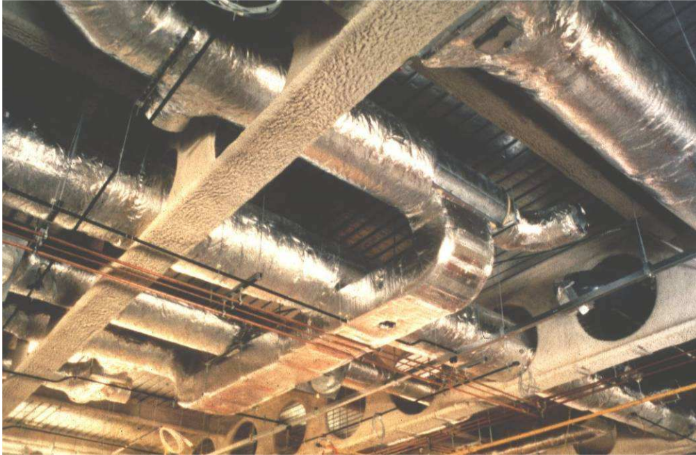
Rys. 4.3 Instalacje rozgałęzają się i przechodzą przez belki ażurowe
