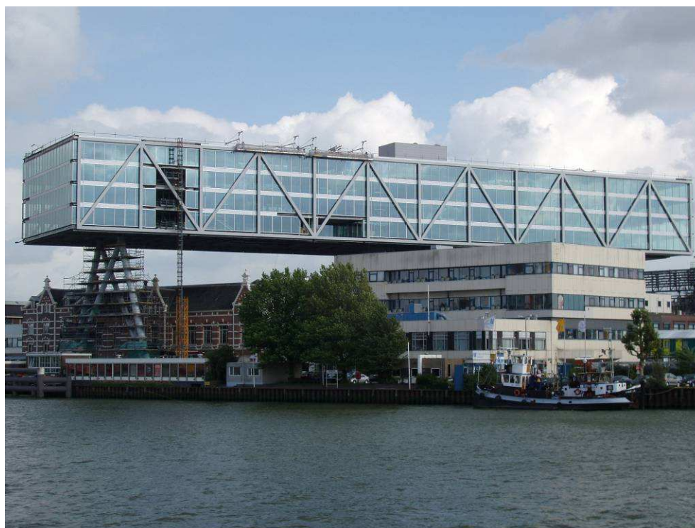
Rys. 4.1 Biurowiec „De Brug” w Rotterdamie, budowany ponad istniejącym budynkiem
