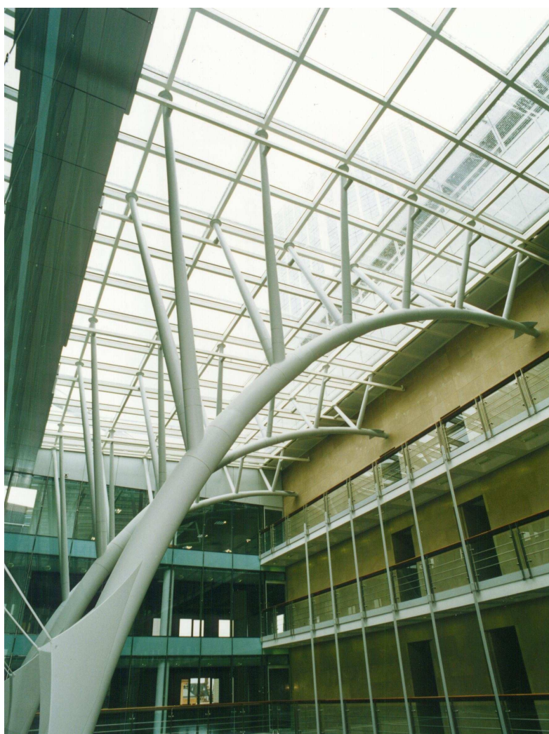
Rys. 3.2 Konstrukcja z rur podpierająca dach atrium
