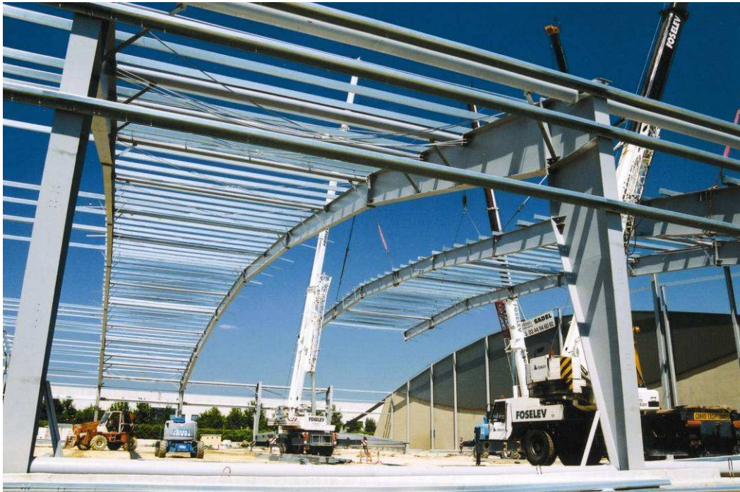
Rys. 2.3 Widok ogólny konstrukcji w czasie montażu
