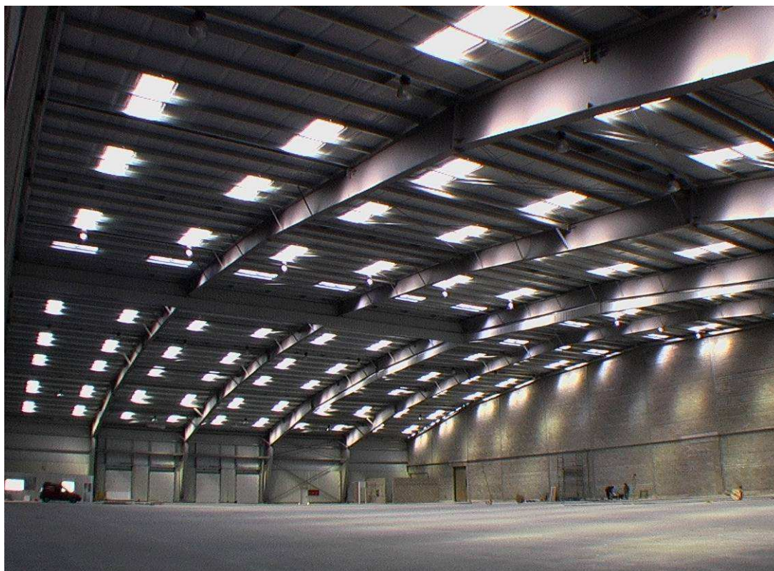
Widok ogólny wnętrza wybudowanej hali, przed montażem systemu regałów magazynowych
