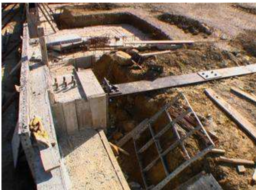
Rys. 2.2 Element rozciągany łączący stopy słupów ramy portalowej
