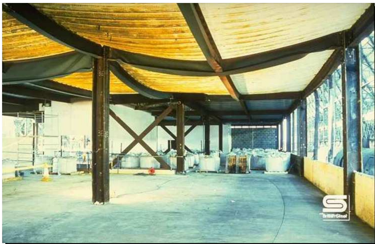
Rys. 3.3 Stalowe belki bez zabezpieczeń podczas badań w Cardington
