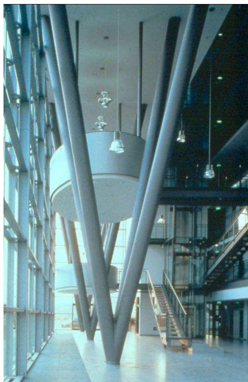
Rys. 3.1 Centrum Innowacji w Adlershof, Berlin
