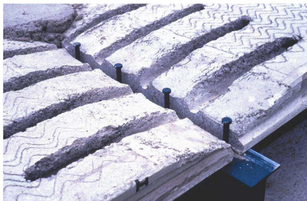
Rys. 3.3 Konstrukcja zespolona z użyciem stalowego deskowania
