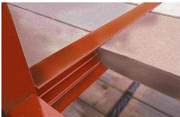
Rys. 3.4 Belki stalowe podpierające prefabrykowane płyty żelbetowe
