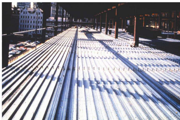
Rys. 3.3 Konstrukcja zespolona z użyciem stalowego deskowania
