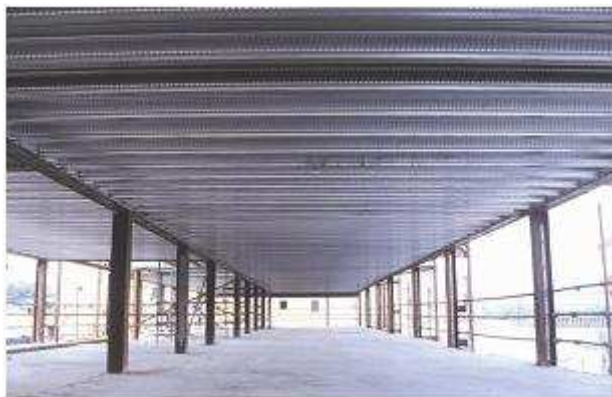
Rys. 3.6 Zintegrowane belki niesymetryczne podpierające płyty zespolone na blachach głębokotłoczonych
