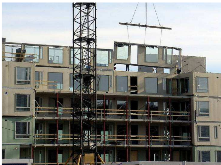
Rys. 4.4 Wznoszenie budynku poprzez montaż nośnych paneli ściennych.
