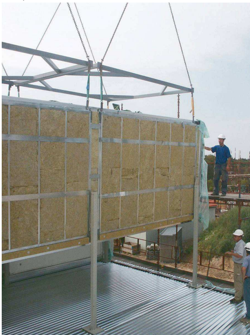
Rys. 2.4 Moduły są transportowane ciężarówkami na plac budowy. Kluczowym problemem jest zapewnienie bezpiecznego transportu modułu. Bezpieczeństwo jest osiągnięte dzięki brezentowym opończom. Na placu budowy moduły są montowane w całość przy pomocy układu słupów stalowych.
