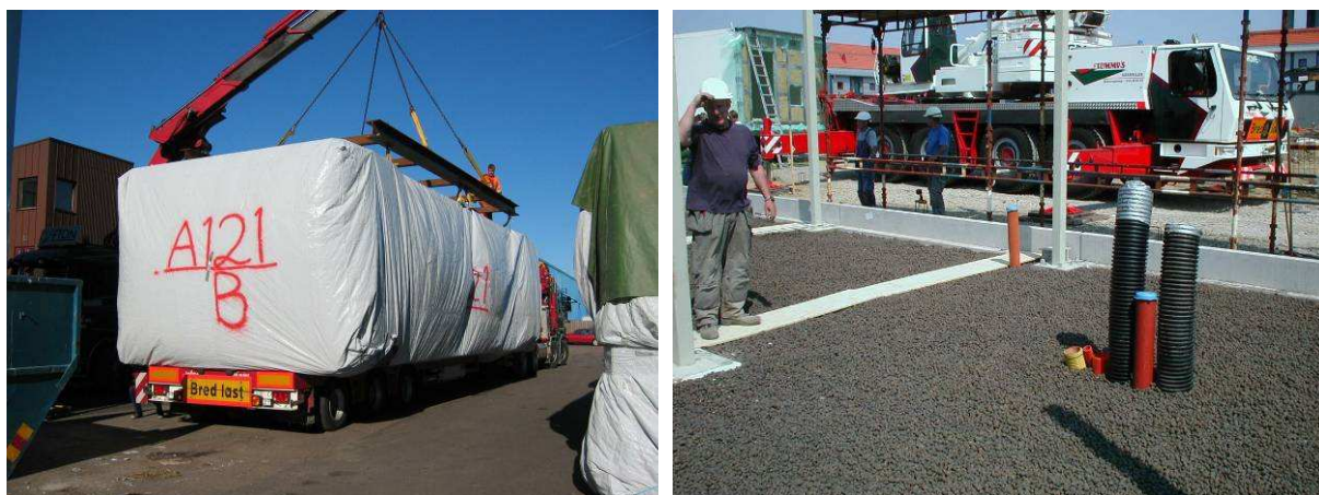
Rys. 2.4 Moduły są transportowane ciężarówkami na plac budowy. Kluczowym problemem jest zapewnienie bezpiecznego transportu modułu. Bezpieczeństwo jest osiągnięte dzięki brezentowym opończom. Na placu budowy moduły są montowane w całość przy pomocy układu słupów stalowych.
