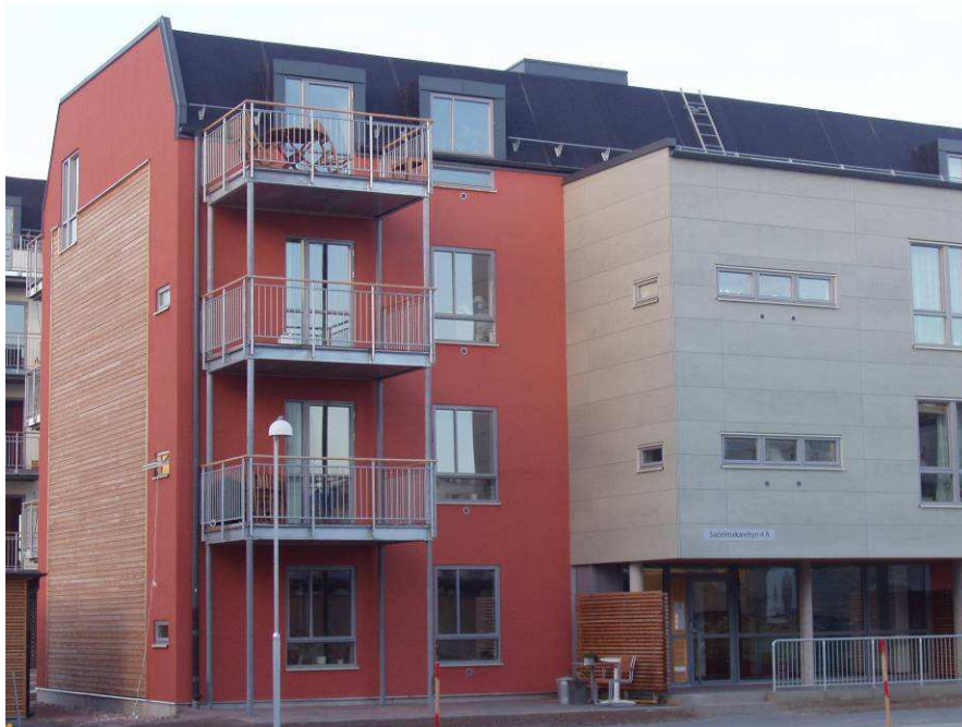
Rys. 1.1 4-ro kondygnacyjny budynek wybudowany w ramach projektu Annestad
