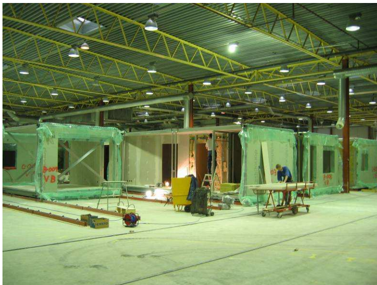
Rys. 2.3 W pełni wyposażone moduły są wykonywane w zakładzie prefabrykacji.
