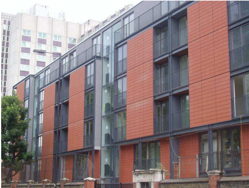
Wykończony budynek na ulicy Lillie Road, Fulham
