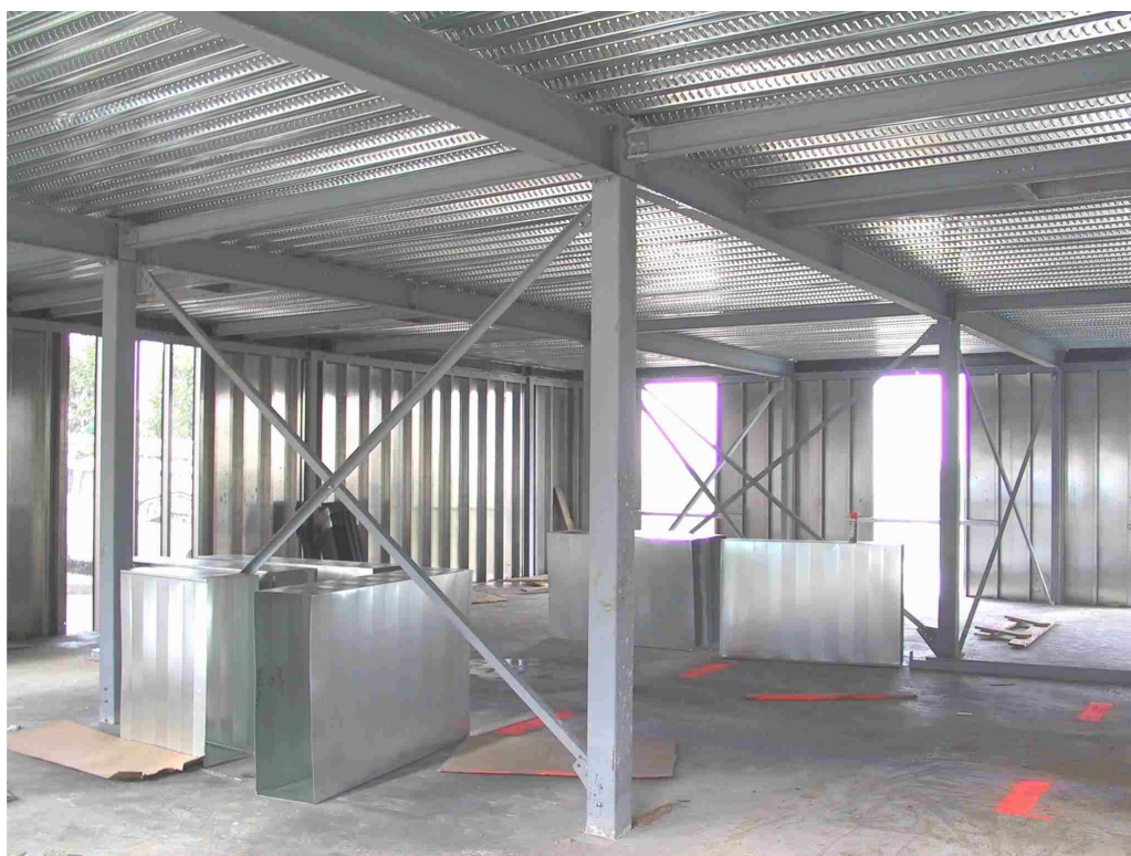
Rys. 3.2 Wewnętrzny widok konstrukcji
