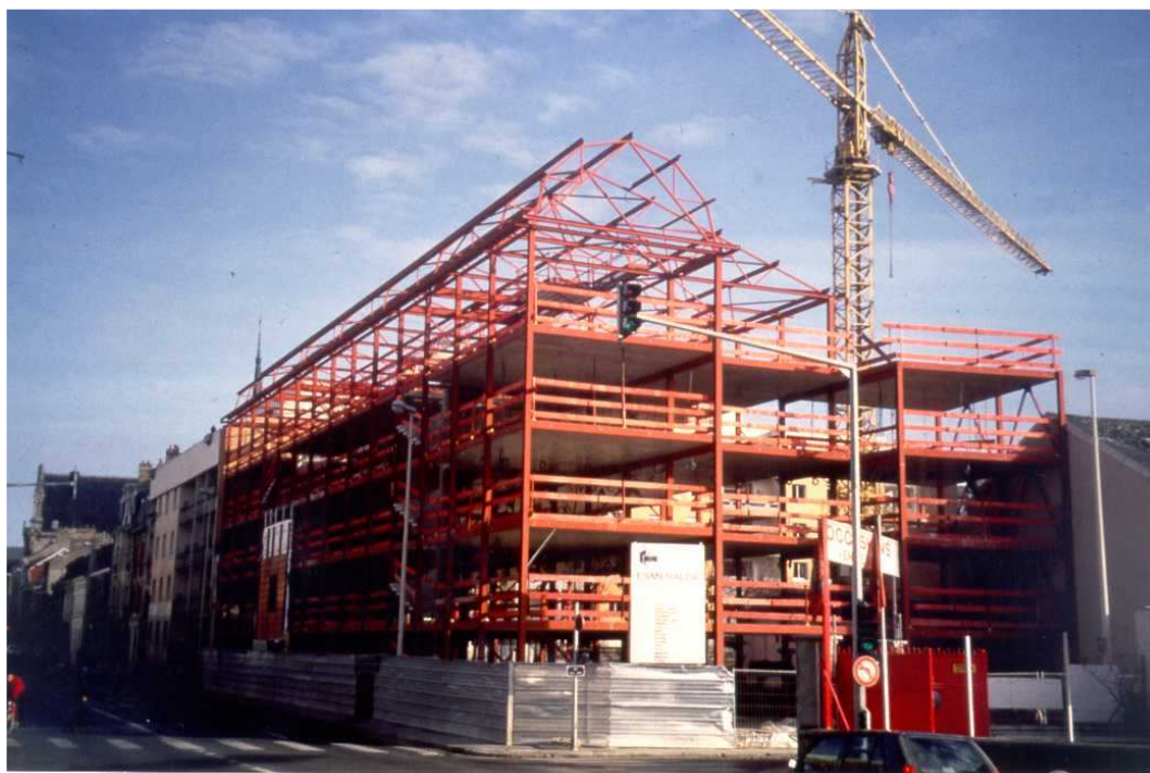
Rys. 3.1 Obiekt podczas budowy
