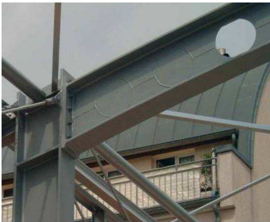
Rys. 2.1 Szczegół połączenia ramy portalowej z belkami ażurowymi
