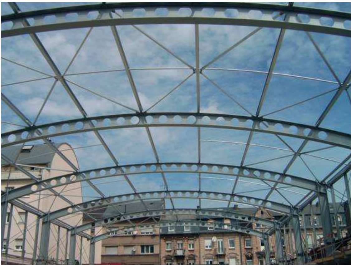
Rys. 1.1 Widok budynku w trakcie budowy
