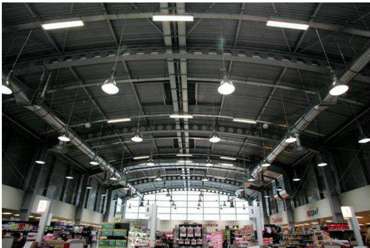
Główna konstrukcja nośna supermarketu
