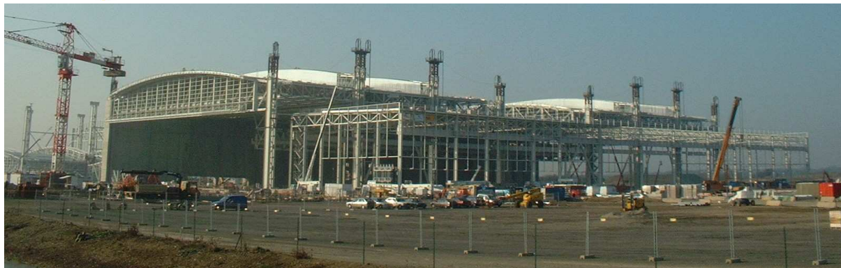
a) Widok zewnętrzny w czasie budowy
