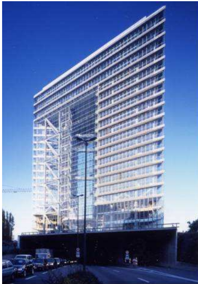
Brama Miejska Düsseldorf, wybudowana nad Rheinuferstrassentunnel (Copyright fotografię zamieszczono za zgodą: Petzinka, Pink und Partner)
