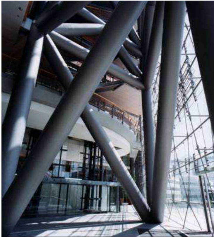
Figure 4.1 Kratowa wieża wykonana z przekrojów rurowych (Copyright fotografia za zgodą ThyssenKrupp Stahl AG)
