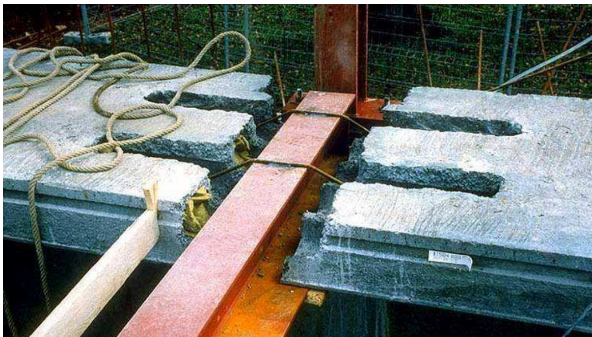
Rys. 3.3 Dodatkowe zbrojenie płyty stropowej ze względów pożarowych
