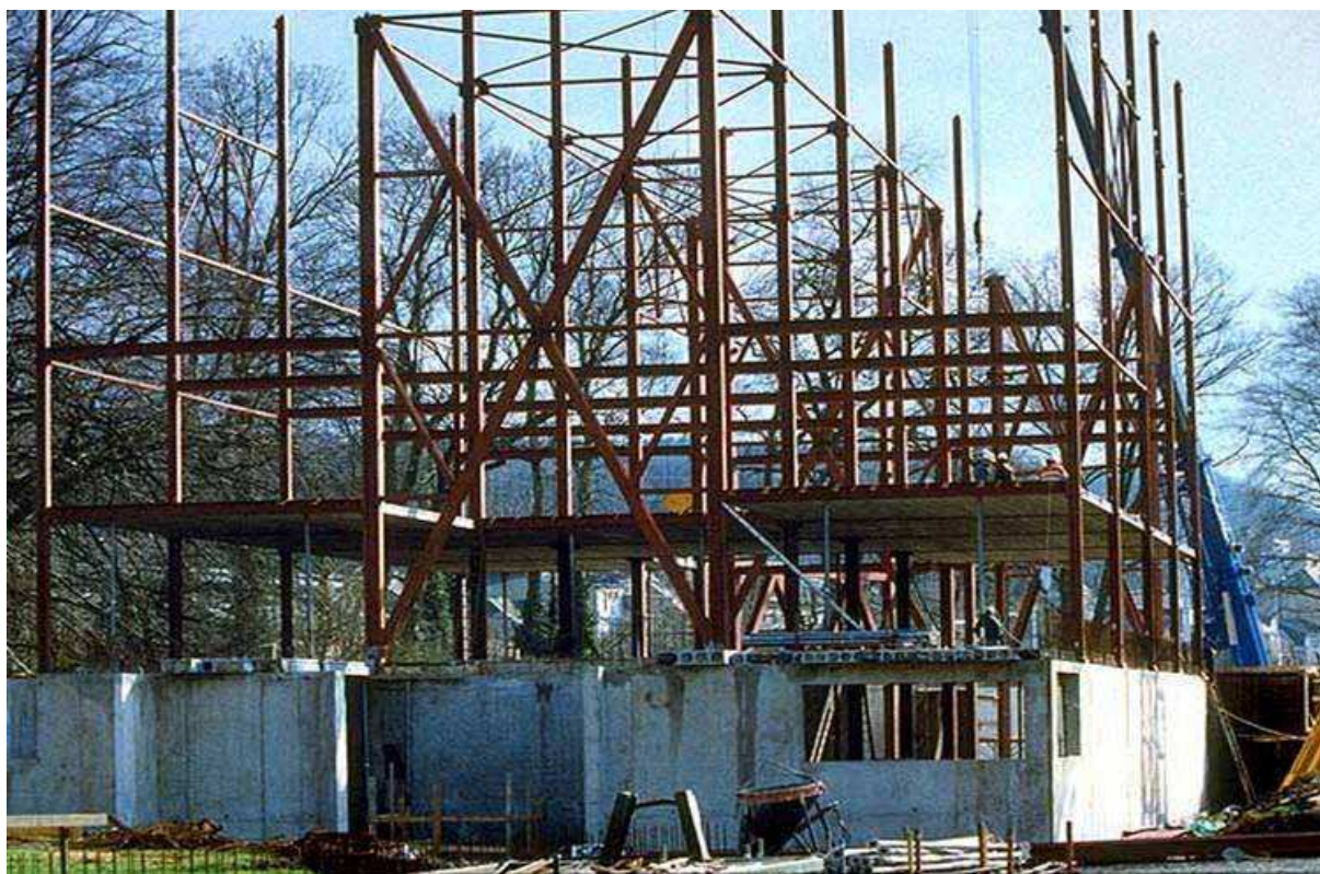
Rys. 3.1 Stalowa konstrukcja budynku w czasie montażu
