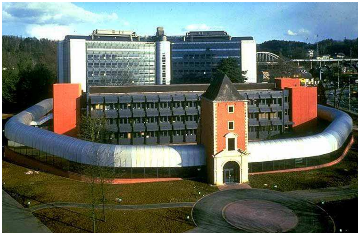
Kompleks biurowy ProfilARBED, Luksemburg
