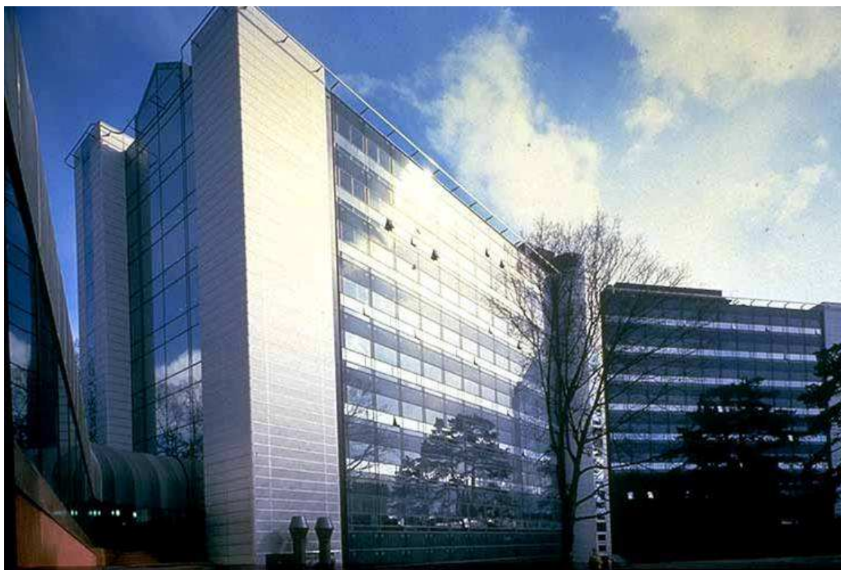
Rys. 2.1 Wykończony 8-mio kondygnacyjny budynek biurowy
