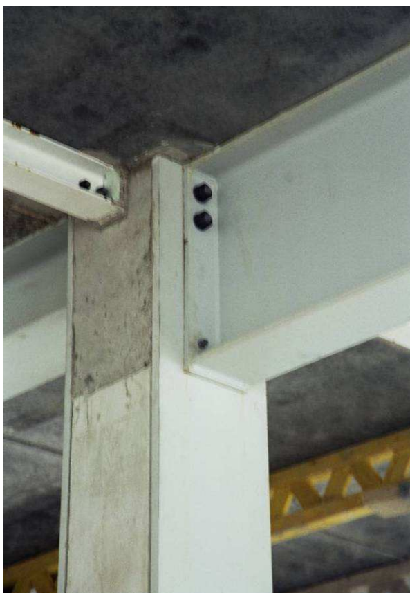
Rys. 4.1 Szczegół połączenia belki z częściowo obetonowanym słupem
