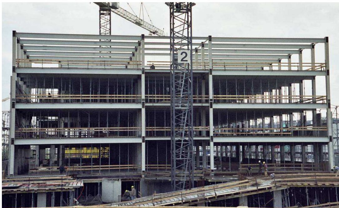
Rys. 3.1 Widok budynku w czasie montażu
