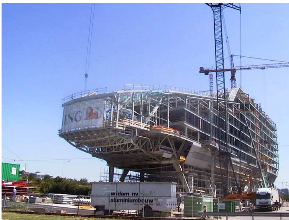
Siedziba główna banku ING podczas budowy
