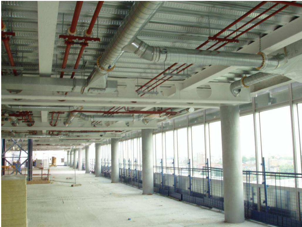
Rys. 2.1 Równoległe belki ażurowe
