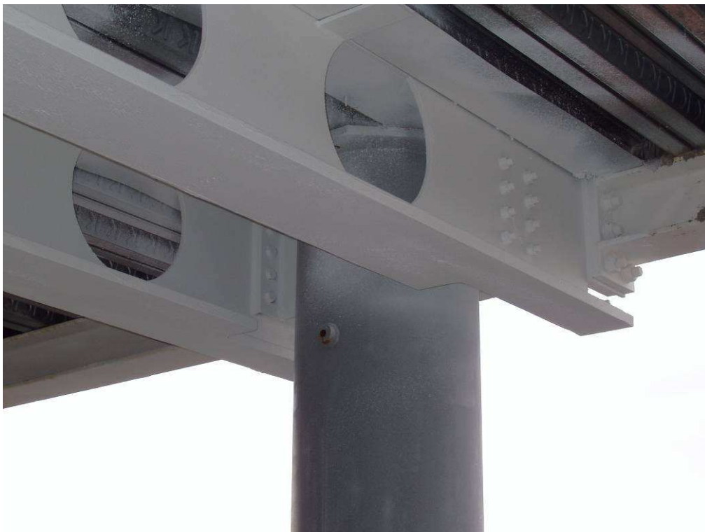
Rys. 2.2 Szczegół połączenia belek z rurowymi słupami
