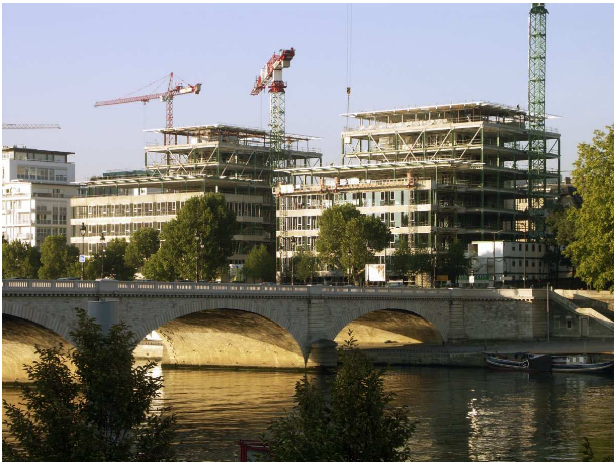
Rys. 1.1 Stan przed zakończeniem – styczeń 2005
