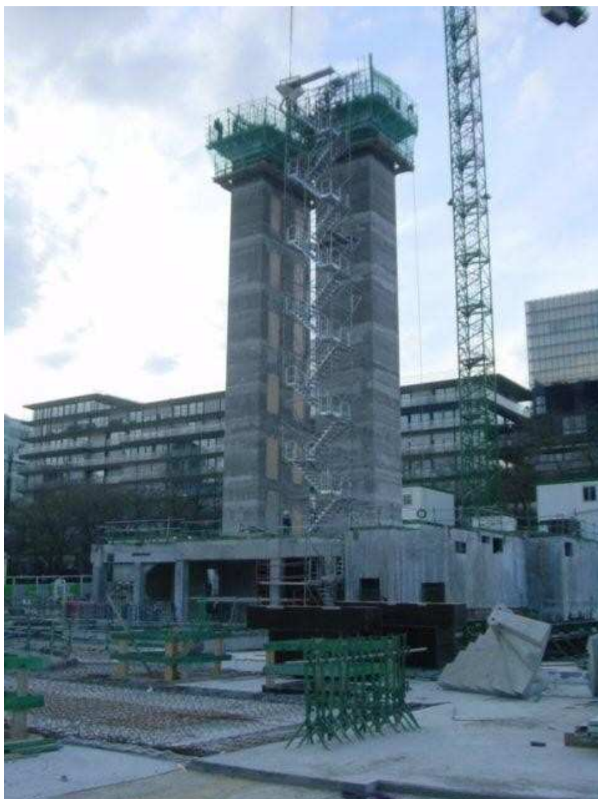
Rys. 5.1 Siedmio piętrowe trzony betonowane w deskowaniach ślizgowych
